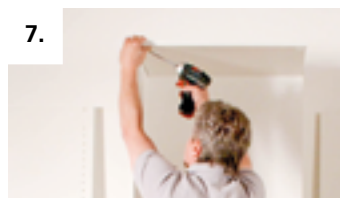
7. Voorste hoek vastschroeven met de accuschroevendraaier. Zo kan de montage probleemloos door één persoon worden uitgevoerd.
