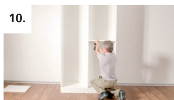
10. Tip: - Bevestig de onderkant aan één kant op de plankdrager en maak de andere kant vast - Vlakliggende schroeven vereenvoudigen de inbouw
