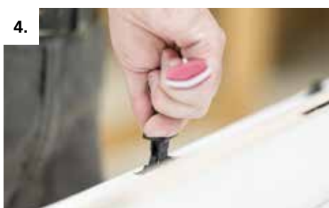
4. Tenso P-14 voorspannen
